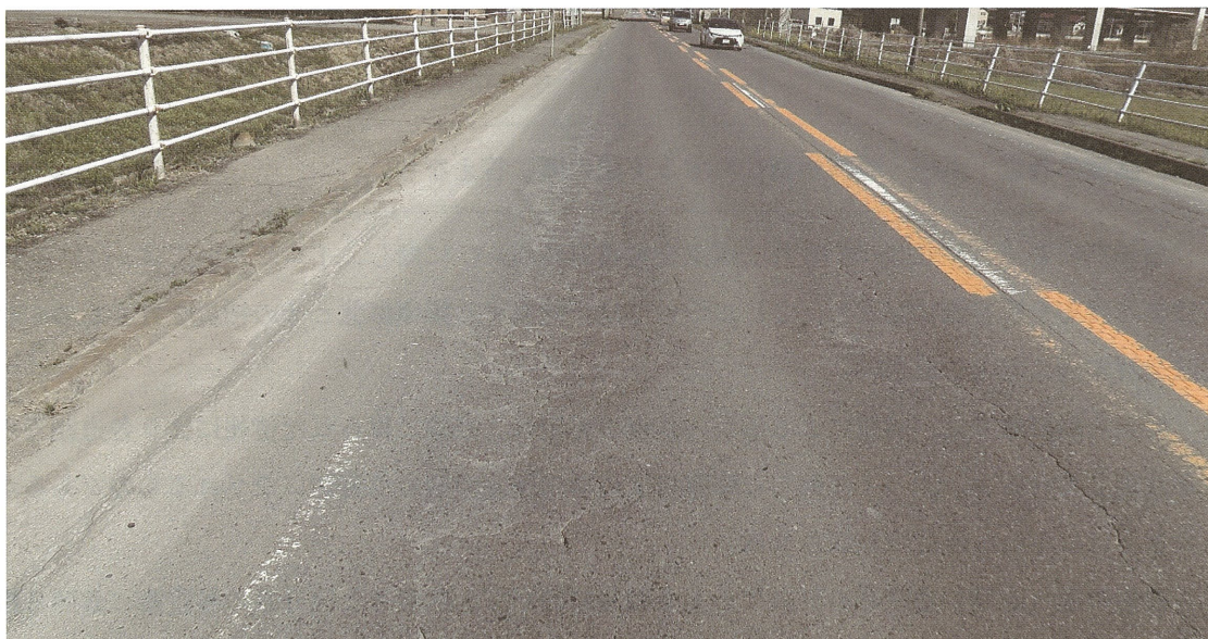
写真3-1 アスファルト舗装の現況
