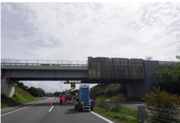
▶工事施工中の高速道路、規制状況
