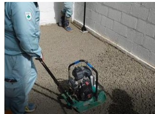
▶ドライテック施工状況
