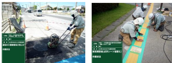
▶雑工 マンホール取替嵩上げ
