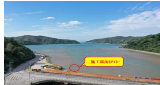
▶工事箇所写真(全景)
