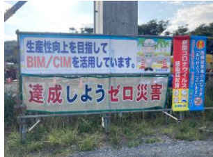
▶BIM/CIM活用工事(受注者指定)
