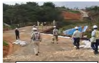
パトロール実施状況 読谷道路1号橋
