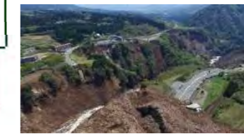
崩落した阿蘇大橋(写真2)
