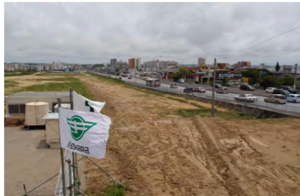
現場全景 (国体道路交差点より南側を望む)
