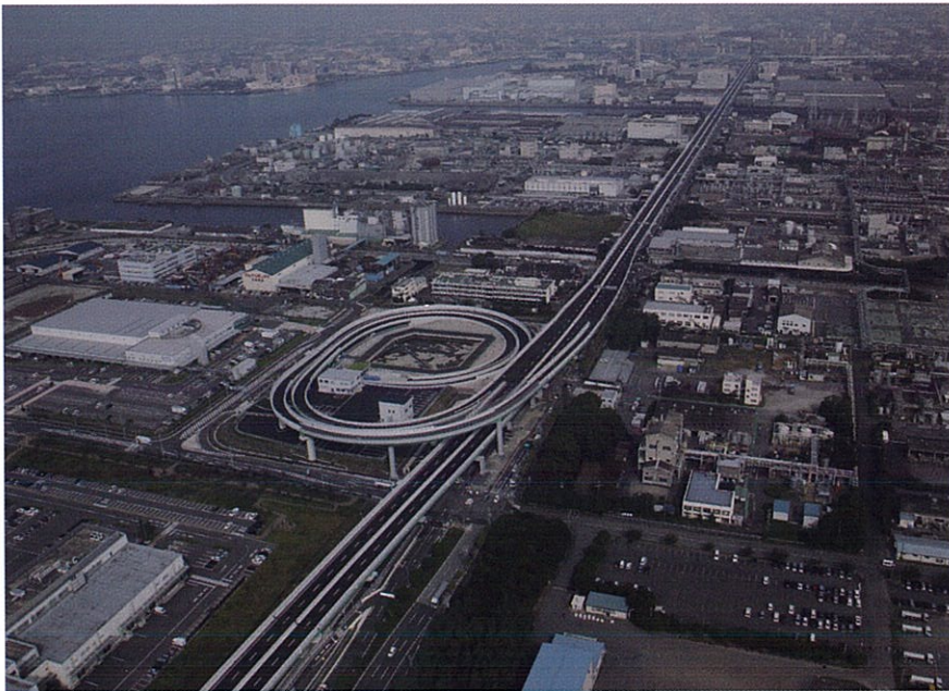
▲船見出入口付近
