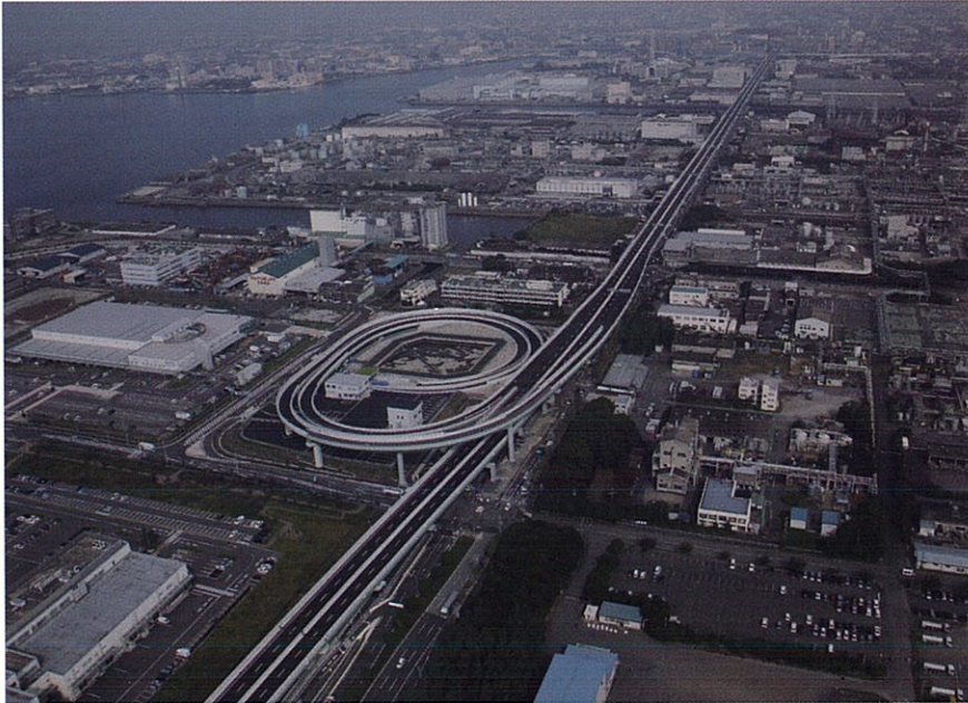
▲船見出入口付近
