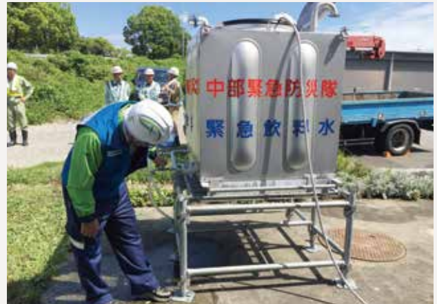
給水タンクの点検
