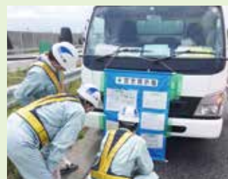
名神高速道路集中工事
