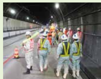
東海北陸自動車道保全工事
