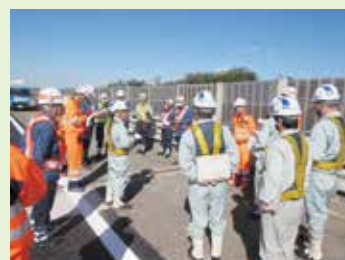
東名高速道路保全工事
