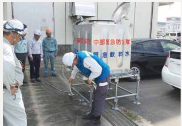
小牧基地：給水タンク点検
