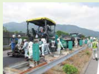
名神高速道路集中工事
