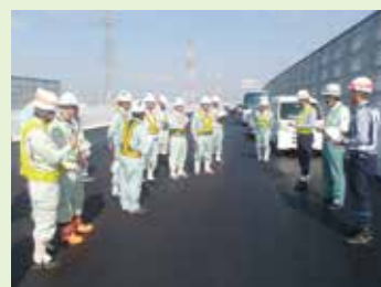
東海環状自動車道建設工事
