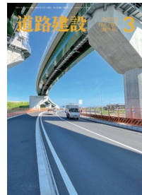
【表紙写真】 寺田拡幅上り線西工区舗装 他工事（京都府城陽市）／明 星建設工業株
