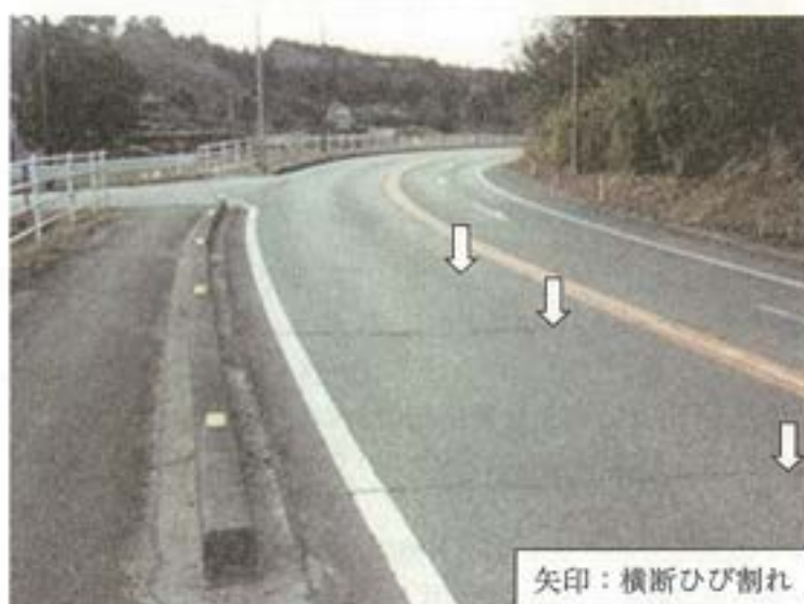
写真3-1 アスファルト舗装の現況
