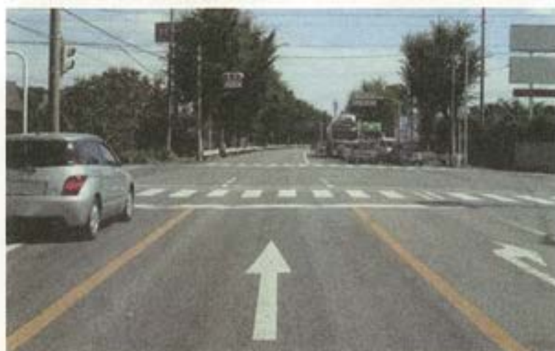
写真5-1 アスファルト舗装の現況
