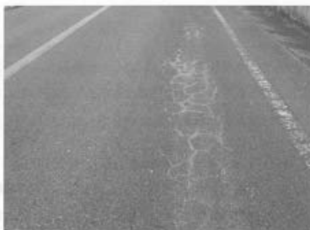
写真3-1 アスファルト舗装の現況
