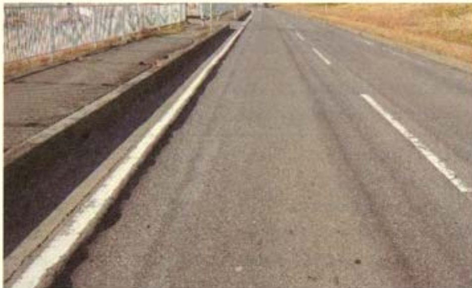
写真 3-1 アスファルト舗装の現況
