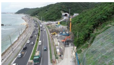
名護東道路数久田 IC地盤改良工事
