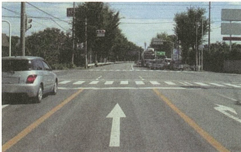
写真5-1 アスファルト舗装の現況
