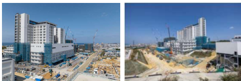
▶琉球大学(西普天間)病院新営その他工事
