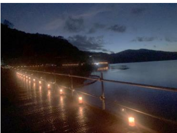
空架け橋② キャンドルイベントにて 仮橋ライトアップ 【土木部 平井 聖子】
