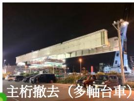
主桁撤去(多軸台車)
