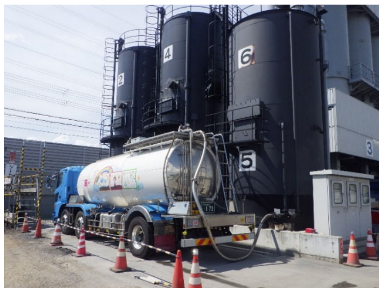
写真-3.1 中温化アスファルトの搬入状況
