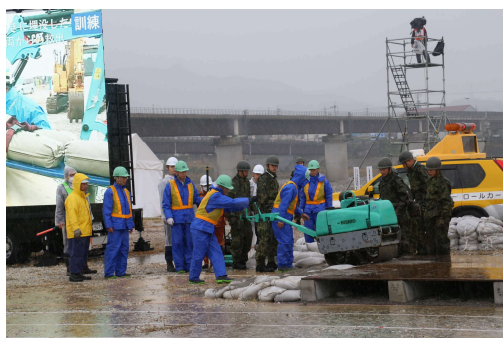
▲ハンドローラーを用い土のうの転圧を実施 滑らないよう土のうの上に砂を散布しました
