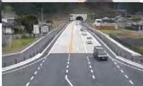
下原トンネル▶
