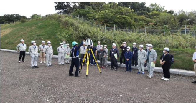
TLS出来形計測の状況
