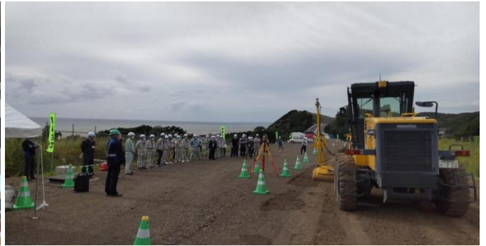
3D-MCグレーダー施工状況
