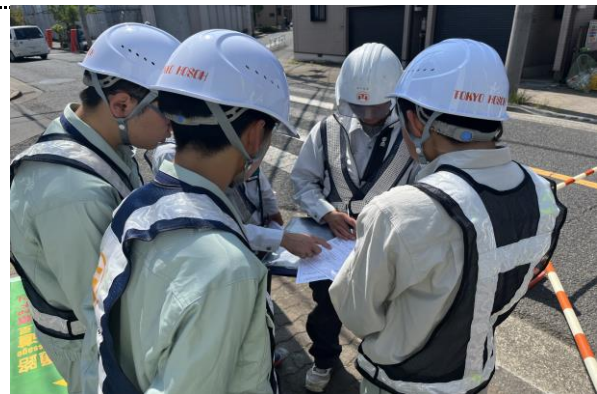
現場代理人による現場概要説明
