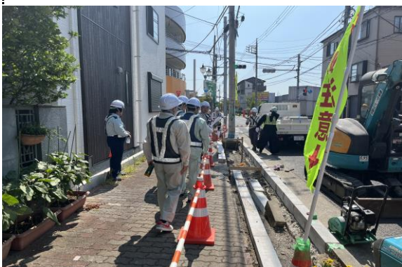
現場の施工状況
