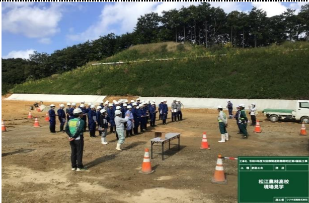
現場概要説明状況
