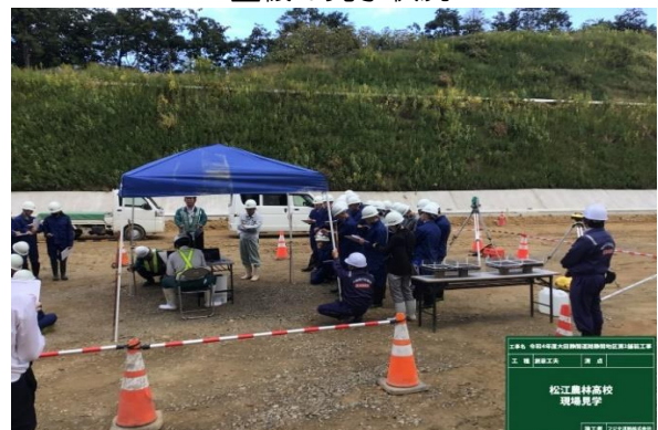
ICT施工動画説明状況
