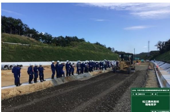
ICTグレーダー施工見学状況
