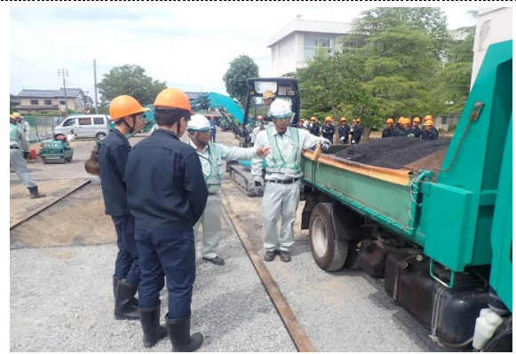
合材到着温度測定
