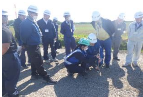
3D測量機器によるワンマン測量
