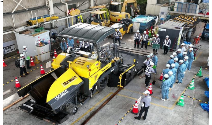
舗装工事実演見学
