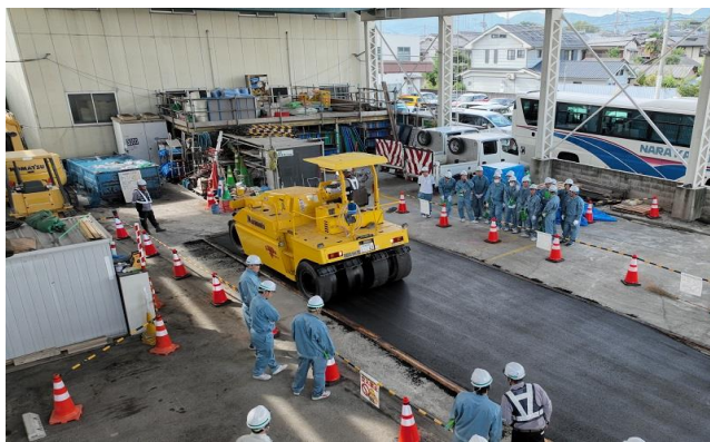
舗装工事実演見学
