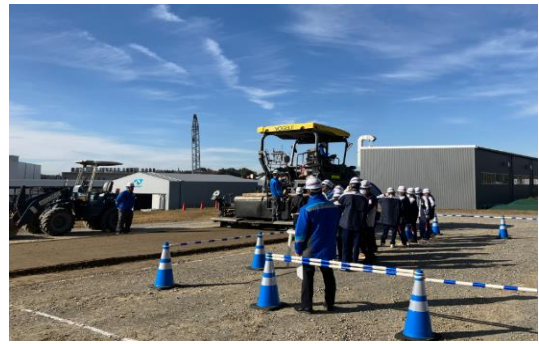
疑似舗装の見学
