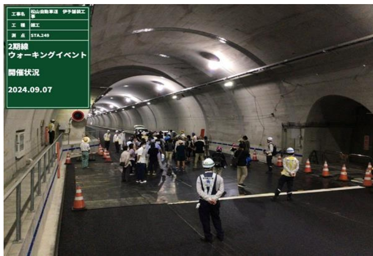
現場見学 (トンネル内及び避難連絡坑)
