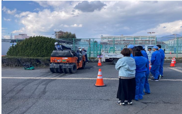
④ローラーによる転圧状況見学
