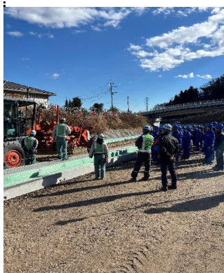
ICT施工現場見学
