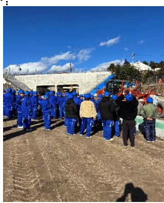
ICT施工現場見学
