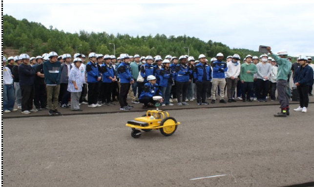
ICT施工の概要説明
