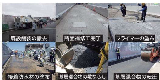
図-9 施工状況
