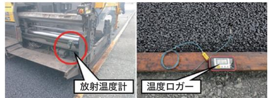
図-9 敷きならし直後の表面温度と内部温度測定状況
