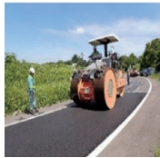
写真－３ 敷きならし 写真－４ 転圧 写真－５ 完成
