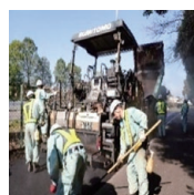
写真－８ 敷きならし 写真－９ 転圧 写真－10 完成
