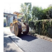
写真－８ 敷きならし 写真－９ 転圧 写真－10 完成
