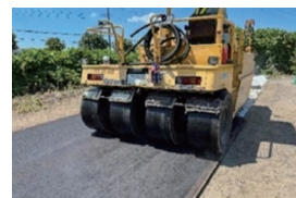
写真-2 試験施工
