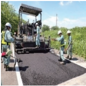
写真－３ 敷きならし 写真－４ 転圧 写真－５ 完成
